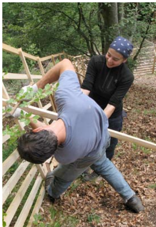
Schutzzaunbau Felsberg, Graubünden, Schweiz
